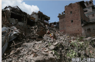
倒壊した建物
